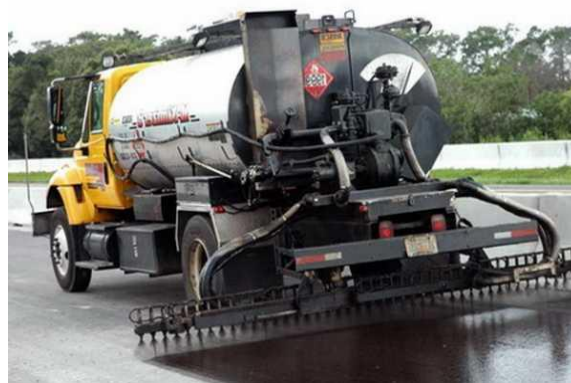
Рис. 1. Пропитка бетонного покрытия
