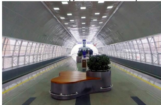
Интерьер станции метро с арочными покрытиями
