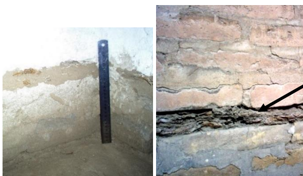
2-расм. Мадраса деворининг пастки қисмини намланиш ва шўрланишдан емирилиши ва ёғоч ётқизикларнинг термитдан зарарланиши
