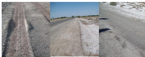
1-rasm. Sho'rlangan gruntli hududlardan o'tuvchi avtomobil yo'llarida yuzaga kelgan deformatsiyalar
