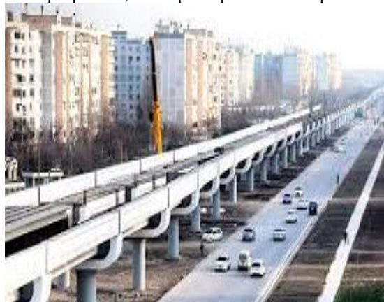
Общий вид эстакады станции метро
