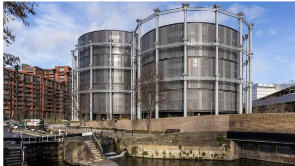
Рисунок-5. Жилой комплекс «Газгольдеры Кингс-Кросс» в Лондоне. Общий вид.
