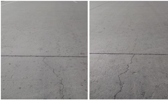
1-rasm. A-380 "G'uzor-Buxoro-Nukus-Beynov" avtomobil yo'lida, ko'ndalang chok yaqinidagi bo'ylama yoriq.
