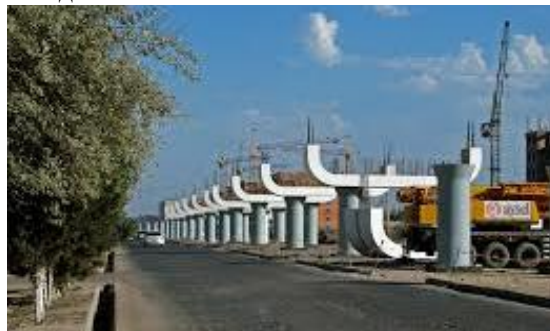
Монтаж конструкции эстакады метро
