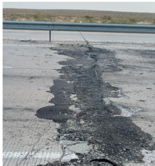
2-rasm. Plitaning kengayishi uchun joy torlik qilganda qoplamaning deformatsiyalanishi.
