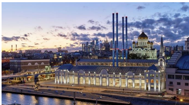
Рисунок-1. Здание дома культуры «ГЭС-2» в г. Москва. Общий вид.
