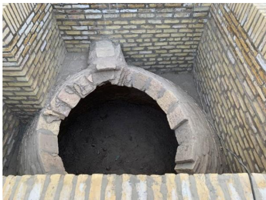
3-расм. Матпанабой мадрасасининг ер ости оқава сувларини чиқариш учун мўлжалланган “тегизамин”ни умумий кўриниши
