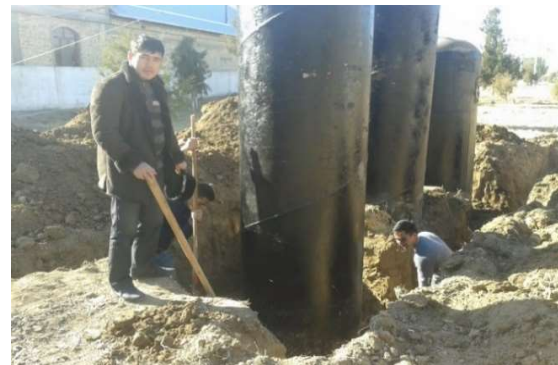
1-расм. Қарши муҳандислик-иқтисодиёт институти ҳудудидаги лизиметрик мажмуани барпо этиш жараёни.
