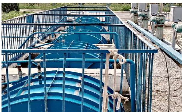
1-rasm. Asaka adir nasos stantsiyasining sifon qismi
