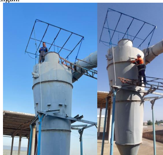
3-rasm. Qurilmaning umumiy montaj ko'rinishi hamda Sensor bloki va filtr moduli o'rnatilishi.
