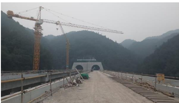
2-rasm. Tunnelni qurishda mexanizatsiyalashgan yer ostini qazib o'tish majmuasi
