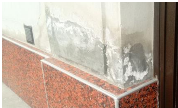
2-расм. Цоколь қисми керамик плитка билан қопланган бино фасади цоколнинг юқори қисмидаги деворнинг намланиши.
