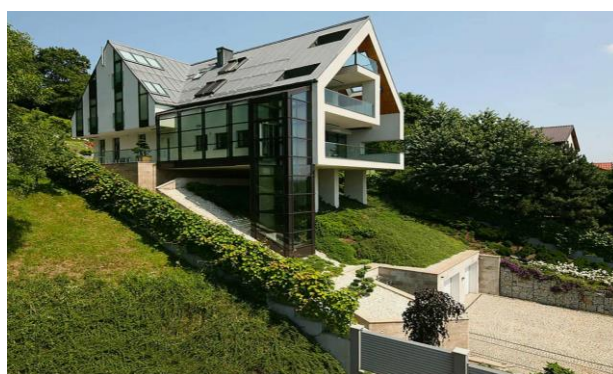
Рисунок 3. Здания на крутых склонах
