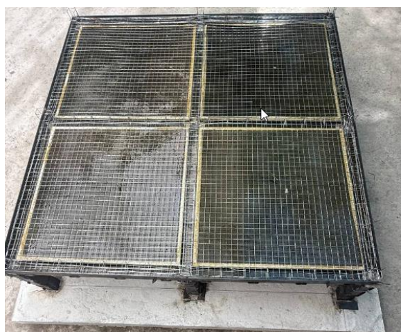
2- rasm. Konstruksiyalarning armaturalanishi
