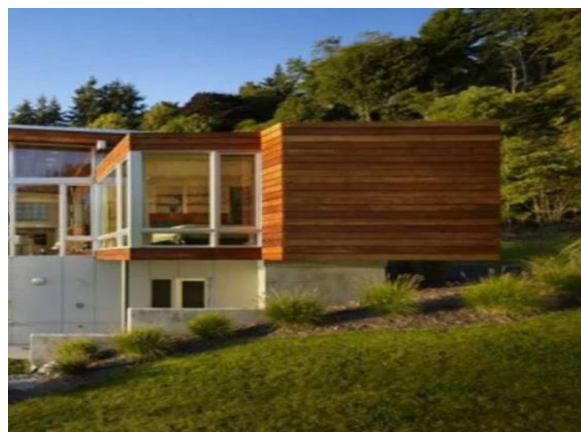
Рисунок 2. Здания, расположенные на небольшом склоне
