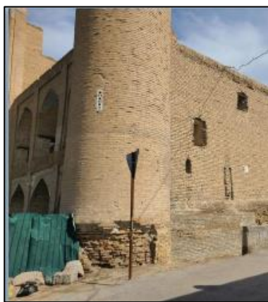
2-rasm. Buxoradagi "G'oziyon" madrasasi: a) – madrasa oldida mashinalar qatnovi bois texnogen ta'sir ko'paymoqda; b) – atmosfera suvlari ta'sirida obida pastki qismida emirilish kuzatiladi.
