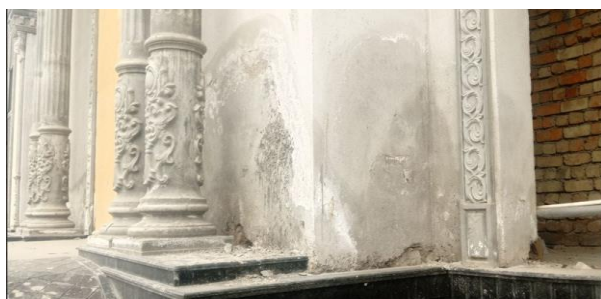
3-расм. Цоколь қисми табиий тош билан қопланган бино фасади цоколнинг юқори қисмидаги деворнинг намланиши.
