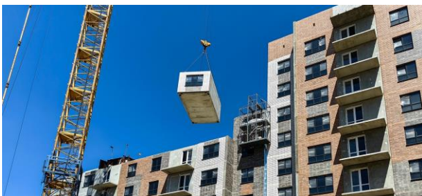
1- расм. Ҳажмий блоклардан барпо этилаётган турар-жой биноси кўриниши
